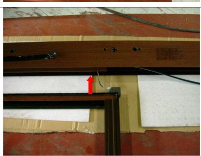
No. 12 たて框の室内側障子レールカバー (樹脂) を取り外す。 はめ込み取り付けしてあり、 取り外 しは容易にできるが、 破損には注意。
