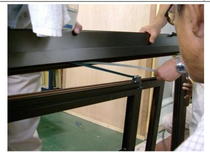
No. 26 たて框の取り付け。 ベル がねじれないように、 内外障子を同じ方向に押し ベル トを張りながらたて框を組み付けする。
