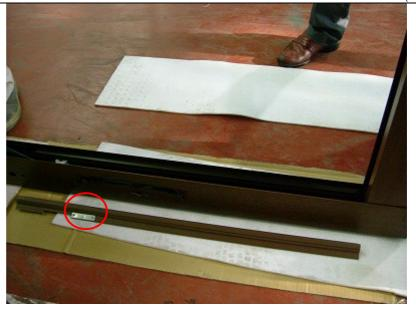
No. 14 プーリ部品が見えたところ。 たて框の室外側障子レールカバーは、 アルヨ形材目板をはめ込み取り付け となっている。
